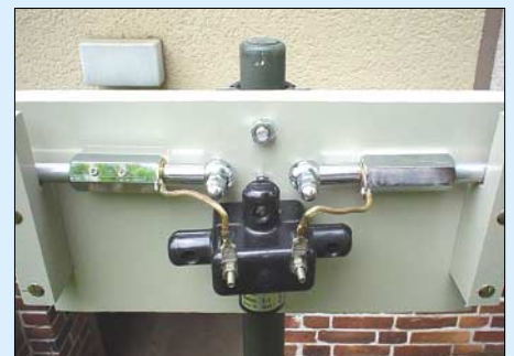
Bild 3: Fertig montiertes Mittelstück; es ist durch zwei Rohrschellen mit Gummieinlagen am Tragemast befestigt. Fotos: DL4OBP
